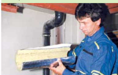
Orstech csőhéj szigetelés beszerelés előtt.
