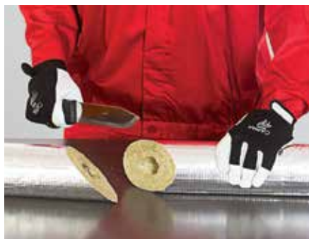
5. kép – A csőhéjat két 45°-os elemre vágjuk
