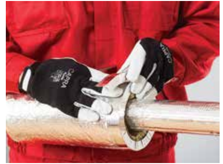
22. kép – A szigetelés lezárása alumínium szalaggal
