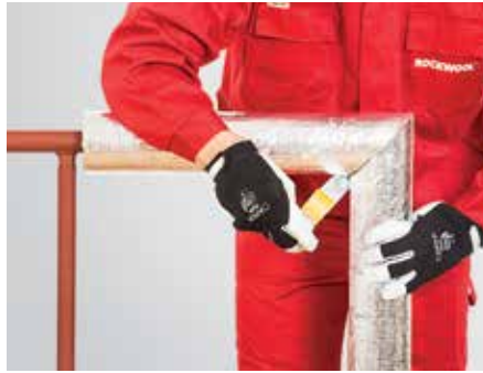
8. kép – Csatlakozások lezárása öntapadó alumínium szalaggal
