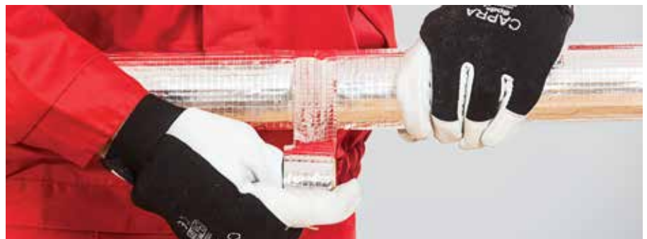
4. kép – Illesztések lezárása alumínium szalaggal
