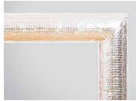
9. kép – Elkészült könyök szigetelés két elemből
