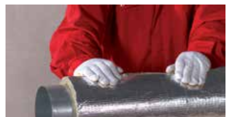
2. lépés – A szigetelés ráhajtása a csatornára
