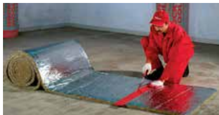
1. lépés – A szigetelés pontos méretre vágása
