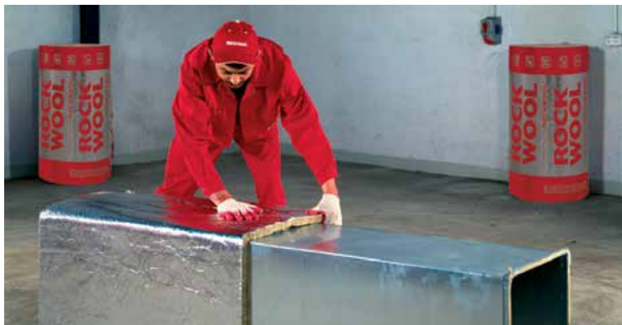
3. lépés – A szigetelés felragasztása
