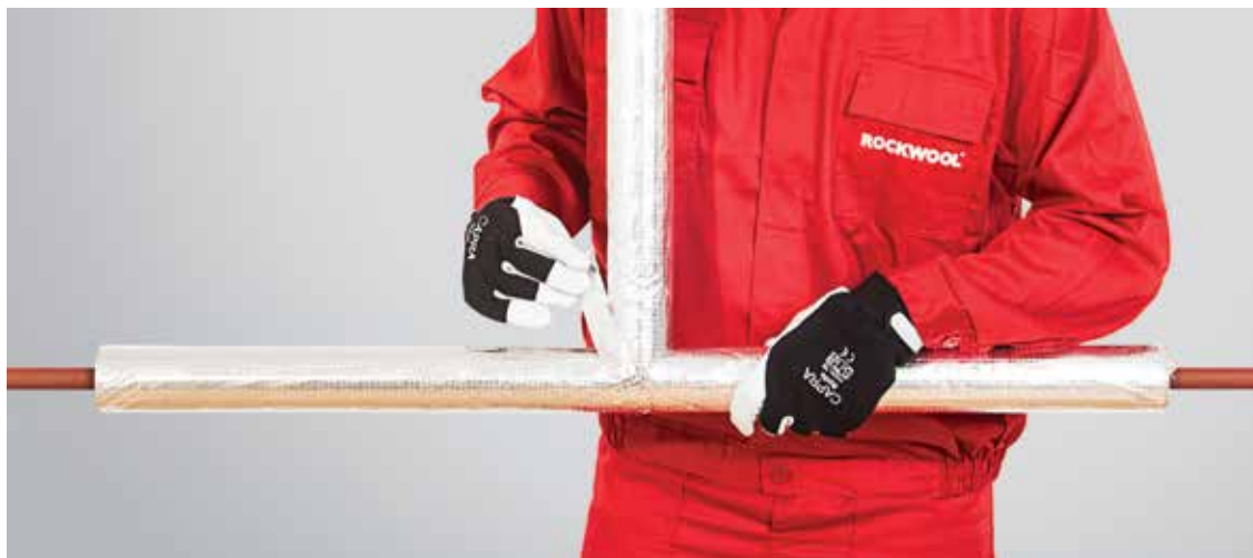
19. kép – Illesztések összeragasztása öntapadó alumínium szalaggal
