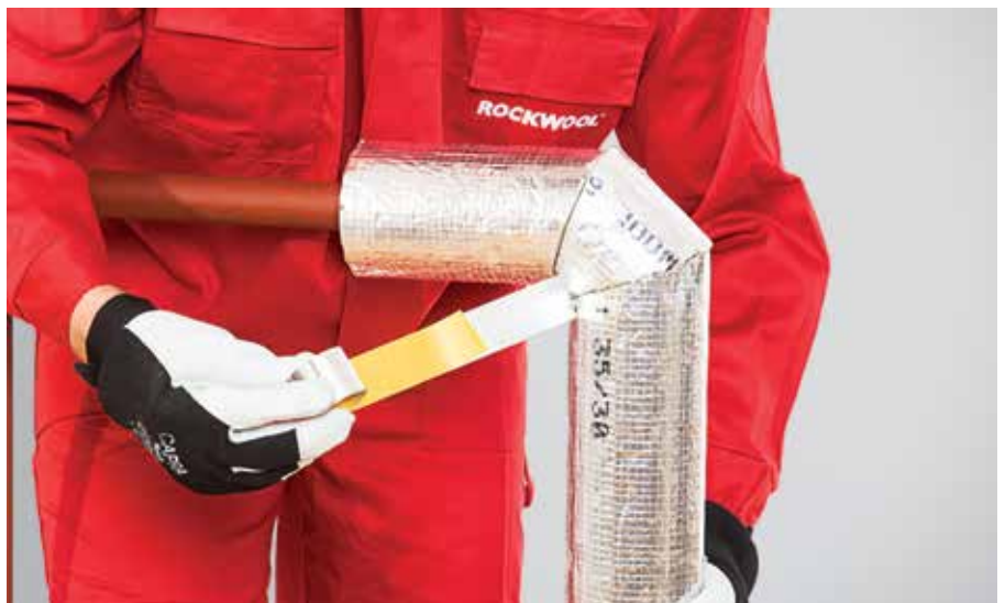
13. kép – Illesztések összeragasztása alumínium öntapadó szalaggal
