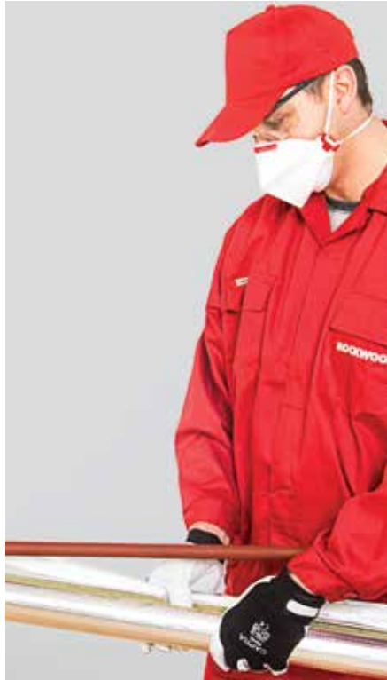
1. kép – A szigetelés felhelyezése
