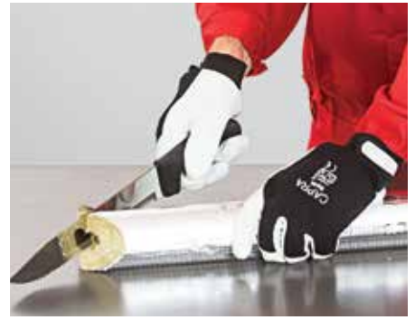
16. kép – 2 \times 45^\circ -os ék levágása a becsatlakozás helyén
